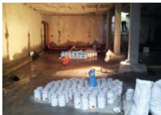
2012 год, Соликамск. Строительство комплекса очистных сооружений. Внутренняя гидроизоляция и химзащита жб резервуаров системой MasterSeal M 336 + P 385.
