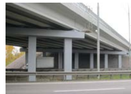
2011 г. Московская область, путепроводы на трассе М5, декоративная защита пролетных конструкций MasterProtect 330 EI RAL 6019, MasterProtect 330 EI RAL 7040 – опор.
