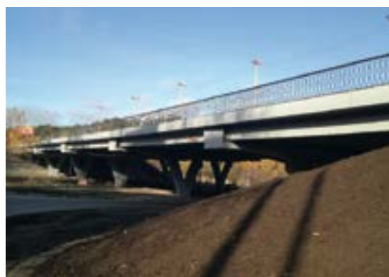
2012 год, Екатеринбург. Капитальный ремонт путепровода. Защитная декоративная окраска жб конструкций и элементов устройства дороги MasterProtect 320 RAL 7040.
