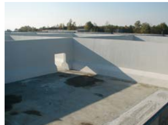
2011 г. Калининградские очистные сооружения. Внутренняя гидроизоляция и защита стен и перегородок аэротенка с применением MasterSeal 588 White.
