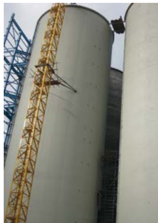
2014 г, Ленинградская обл., г. Сланцы, цементный завод. Силосы хранения сырья. Внешний вид покрытия MasterProtect 320 спустя 5 лет эксплуатации.
