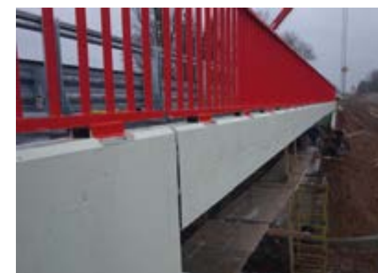
2013 г. Мост через реку Зарезница на км 301+469 автомобильной дороги М-20 Санкт-Петербург–Псков–Пустошка–Невель до границы с Республикой Беларусь, Псковская область. Защитное покрытие MasterProtect 330 EI
