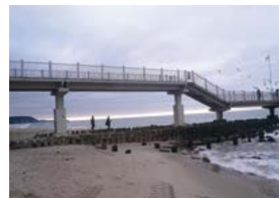
2003 год, Светлогорск. Капитальный ремонт променада «Капитанский мостик». Гидроизоляция и защита пролетных сооружений и опор MasterSeal 588. На фото мониторинг объекта в 2013 году.
