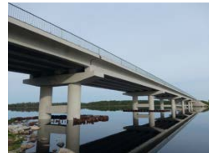
2013 г. Мурманская область. Реконструкция искусственных сооружений а/д Р-21 «Кола» СПб-Мурманск. Гидроизоляция и защита опор и пролетных строений MasterSeal 588 White.
