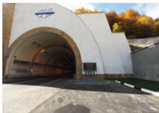
2010 год, р-ка Дагестан. Защита сводов Гимринского Автомобильного Дорожного тоннеля на всем протяжении 4350 м с применением MasterProtect 320 RAL 9010.
